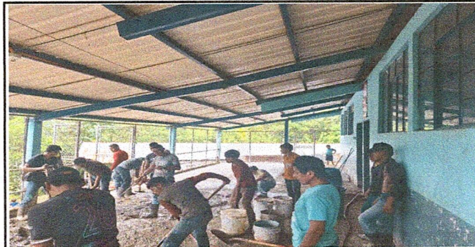
Foto 4: Inicio de la reparación del corredor de los 2 módulos
