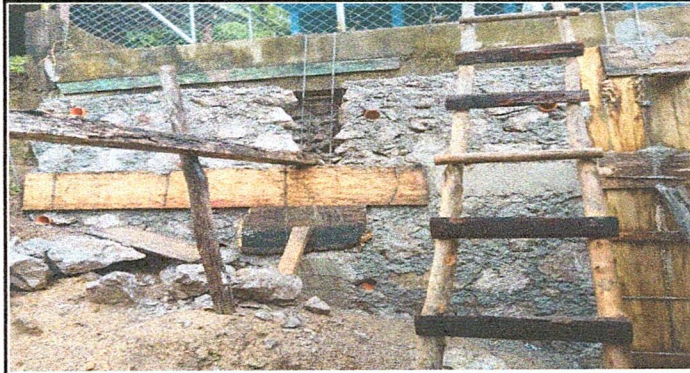
Foto 2: a un 90 % de la reparación del muro de contención del módulo 2
