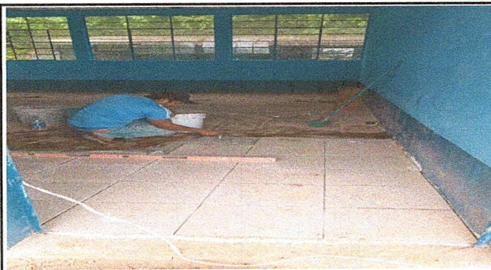
Foto 3: Colocación de piso en las aulas en los 2 modulos
