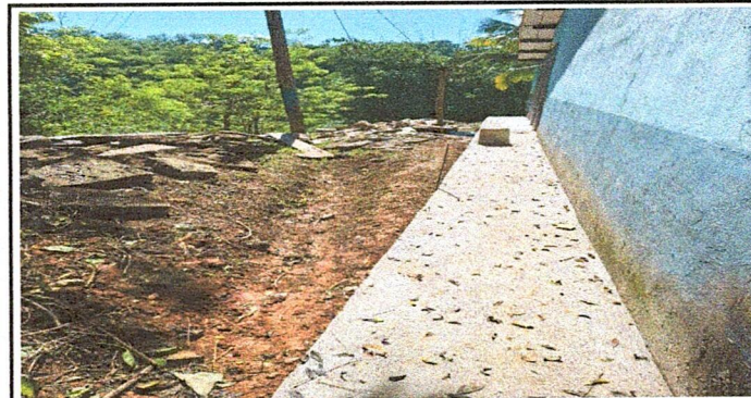
Foto 6: 75 % de avance de la reparación de banqueta lateral del modulo 1
