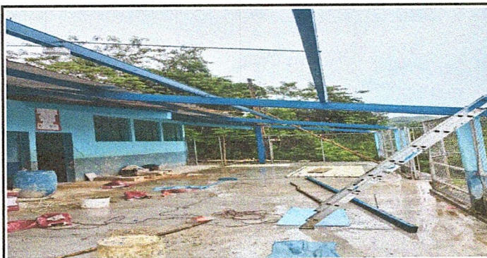
50% de reparación del techo del corredor del modulo 2
